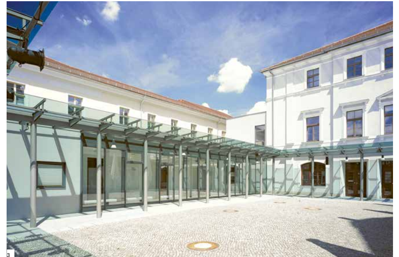
3 | Umbau und Sanierung eines historischen Gebäudes unter den Bedingungen des Denkmalschutzes: Staatsschauspiel Dresden, Kleines Haus, Architekt: Architekturbüro Wagner, Dresden
