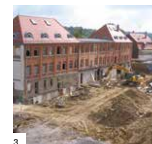
1 | Fassade erneuert, Decken erhalten, Erschließungsspanne ergänzt: Strickfabrik in Weissach, Architekt: HansUlrich Benz, Weissach 2 | Konstruierte Vorderansicht 3 | Freilegung der Untergeschosse 4 | Entkernung des Gebäudes bis auf die Fassade
