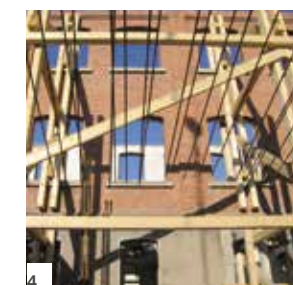
1 | Fassade erneuert, Decken erhalten, Erschließungsspanne ergänzt: Strickfabrik in Weissach, Architekt: HansUlrich Benz, Weissach 2 | Konstruierte Vorderansicht 3 | Freilegung der Untergeschosse 4 | Entkernung des Gebäudes bis auf die Fassade
